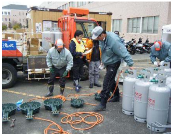
避難所へのLPガス供給
