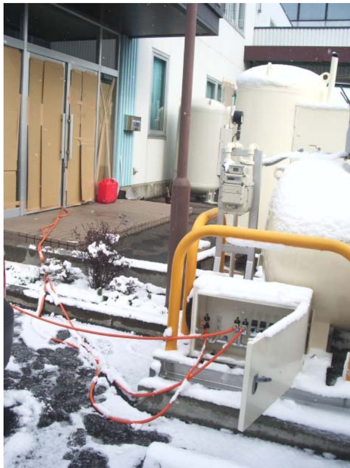
災害対応バルクユニットの収納ボックスを開きガス栓ユニットにホースを接続。
