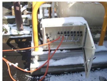
ガス栓ユニットにホースを接続
